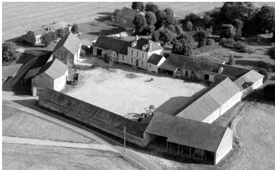
La ferme du Grand-Villiers (Arrancourt)
